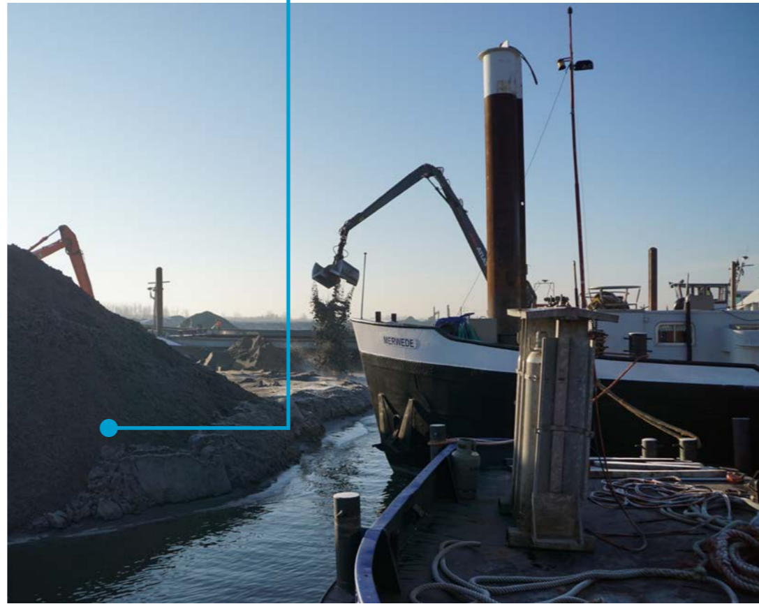
In totaal wordt er ca 480.000 m3 zand toegepast dat aan hoge standaarden dient te voldoen om de krachten van het water aan te kunnen. Daarom wordt zand met een grote korrel (D50) toegepast.
