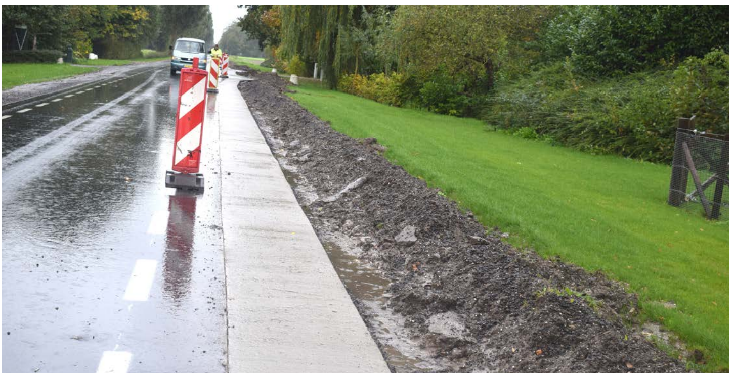
Creilerpad, aangebracht bermbeton.
