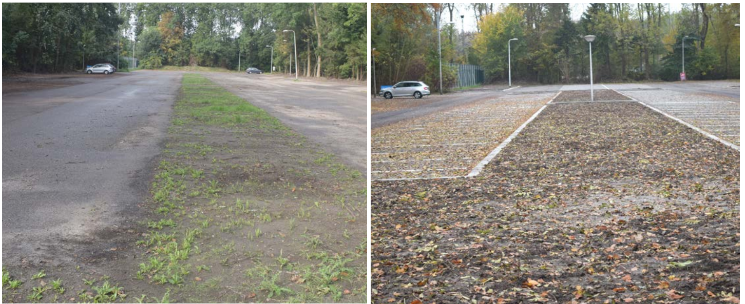
Parkeerterrein Sportpark De Boskamp voor en na de reconstructie.
