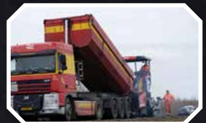
ASFALTEREN HARDERDIJK DRONTEN PAG. 14.15
