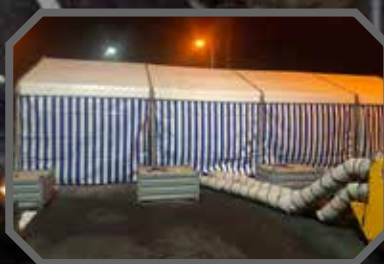
Brugonderhoud-18 Westerwoldse Aa
