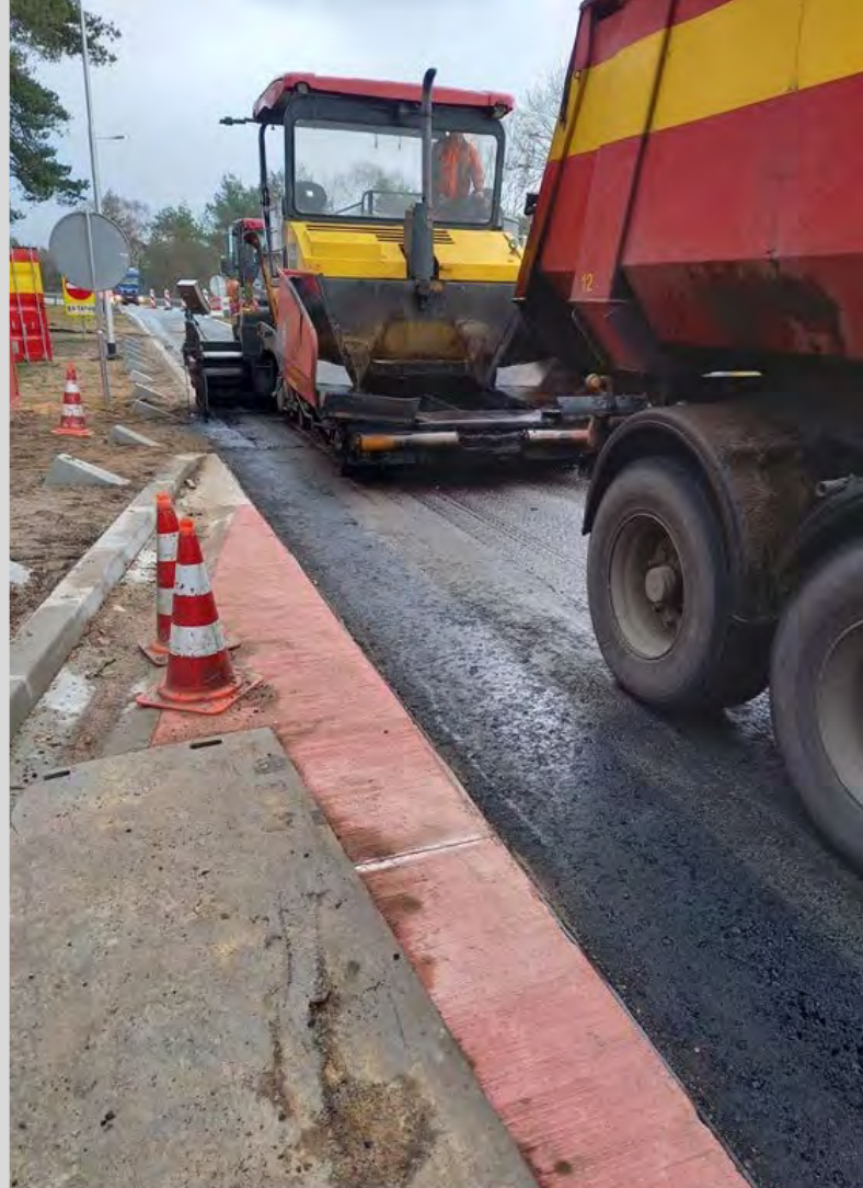
Foto: nieuw asfalt aanbrengen
