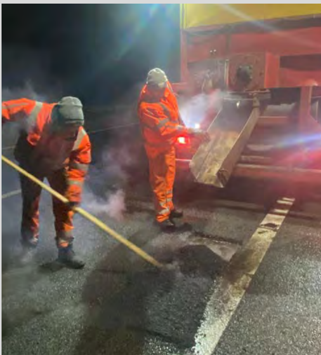
Foto's: het gefreesde vak wordt gevuld met asfalt
