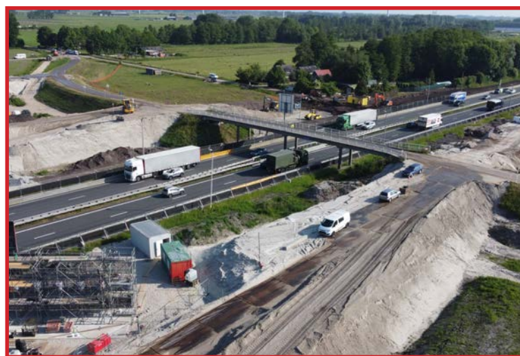
Oude viaduct (gesloopt)
