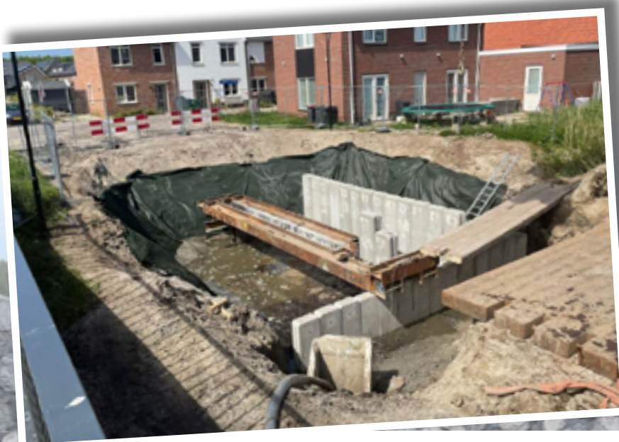
Fundering brug Hendrik Lorentzweg
