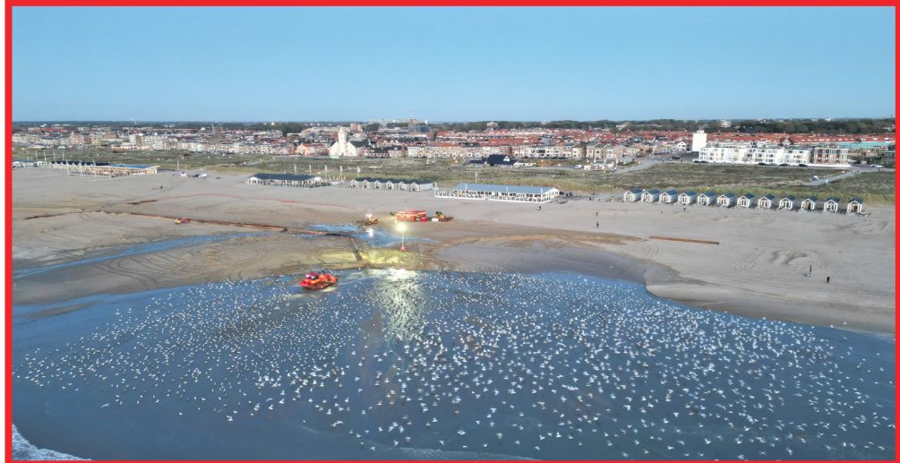
Verdelen van het opgespoten zand bij de strandleiding
