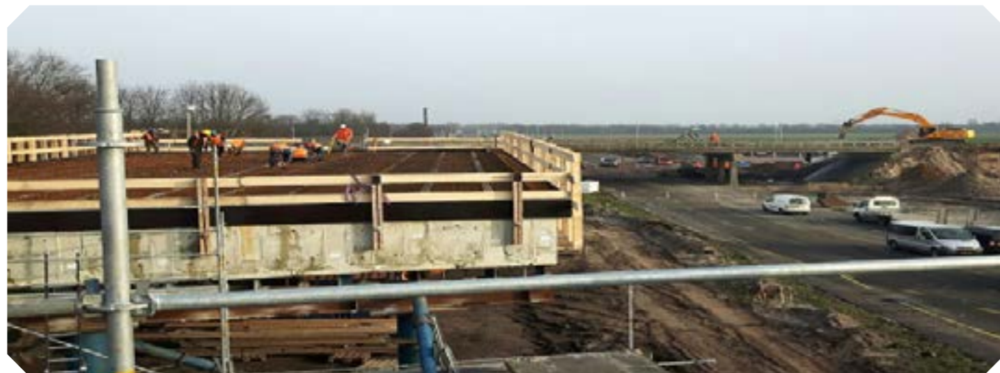
Terwijl op de achtergrond de sloopwerkzaamheden nog volop aan de gang zijn wordt op de voorgrond aan een van de nieuwe brugdekken gewerkt - januari 2018.
