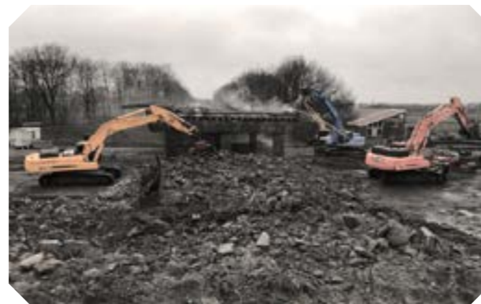
Sloop oude viaduct - januari 2018.
