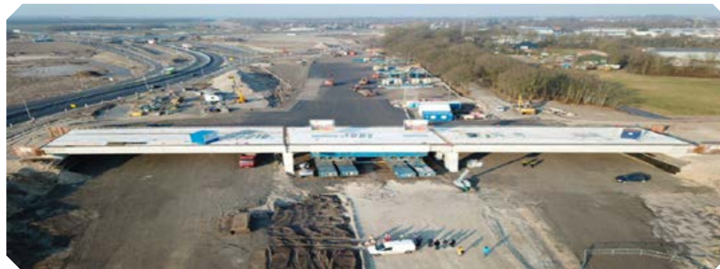
Het laatste (middelste) dek is ingereden. De onderstellen zijn nog zichtbaar. (zie ook pagina 6 en 7 voor meer details over het inrijden van de brugdekken)
